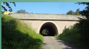
Bild 1: Die Unterführung als einzige Möglichkeit, die Autobahn zu überqueren.
