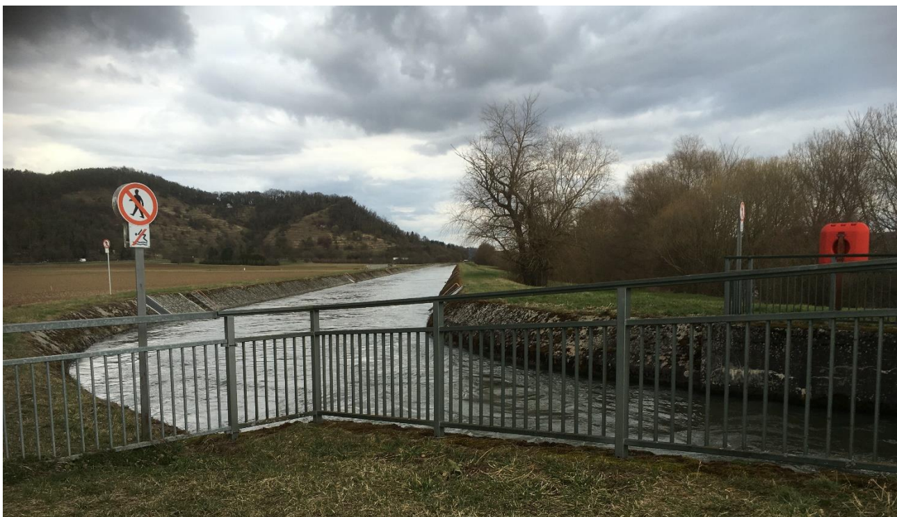
Bild 20 Gebiet 10 - Betonierter Neckar-Ober-Kanal
