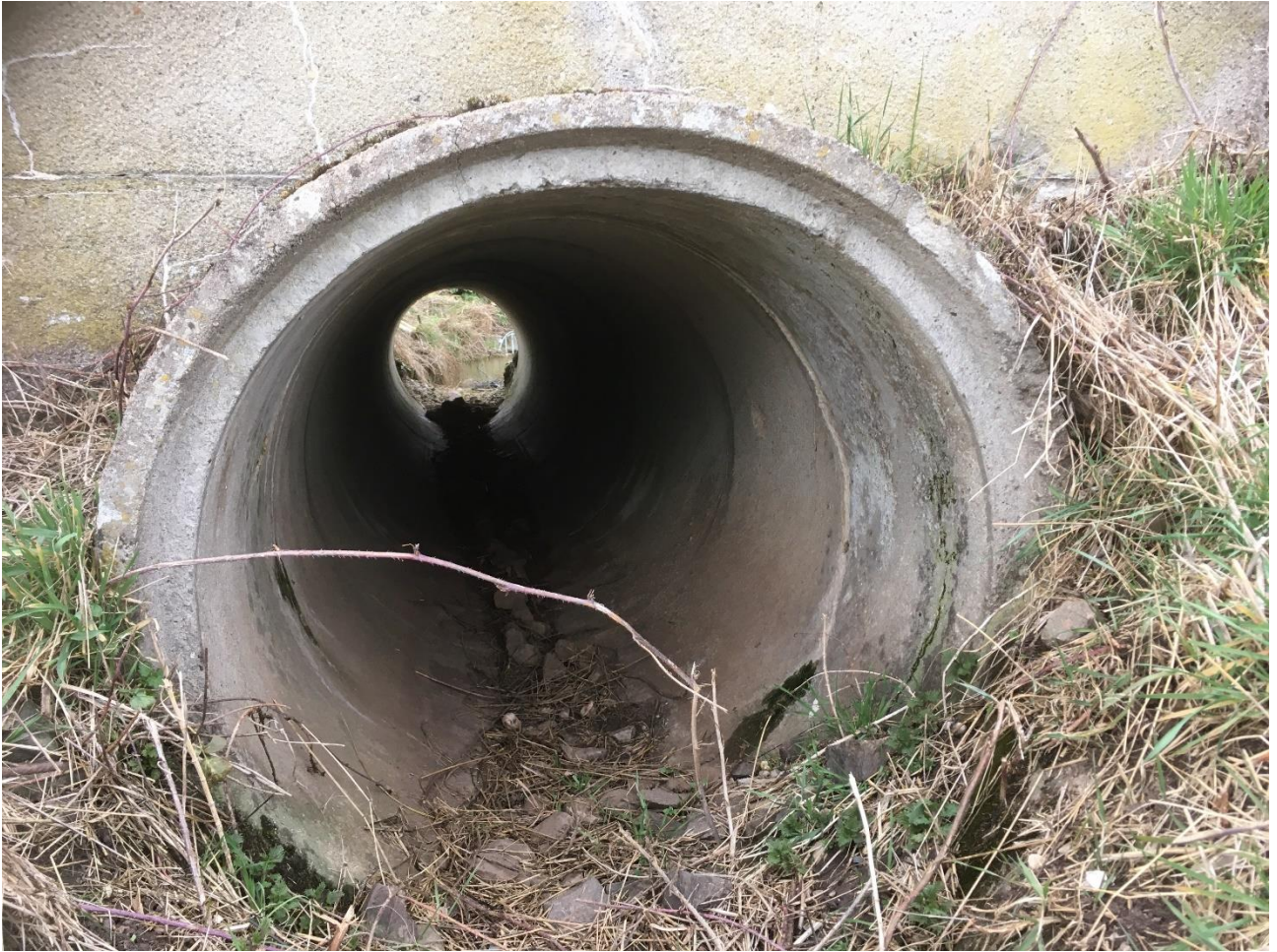
Bild 23 Gebiet 10 - Betonröhre unter den Schienen der Oberen Neckarbahn
